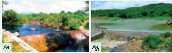
படம் 8.4: TAP திட்டத்தின் கீழ்க் கட்டப்பட்ட கட்டுமானங்கள் அ. தடுப்பணை ஆ. வழிந்தோடும் குளம்
